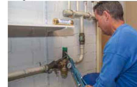
Der AQUABION® wird direkt nach der Wasseruhr der Stadtwerke installiert.
