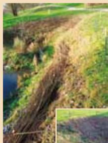
Einbau von Weidenfaschinen zur Erosionsminderung am freigelegten Haselbach
