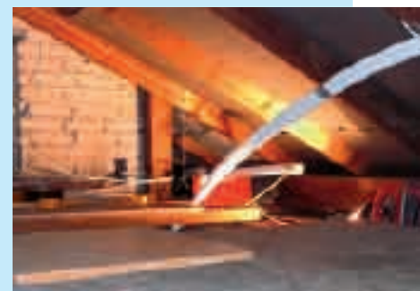
Ein Blick unters Dach
