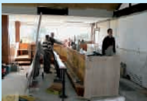
Einbau der neuen Theke
