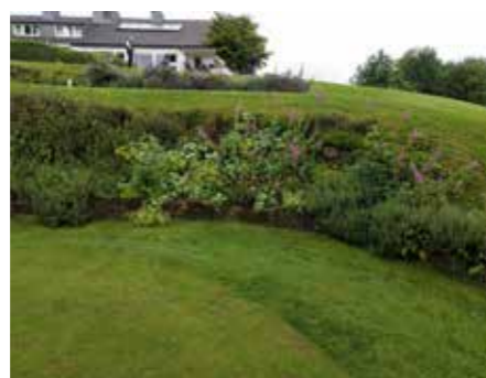
Trockenmauer am 10. Abschlag Ostplatz
