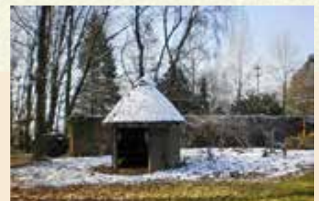
Freischnitt der Wetterschutzhütten
