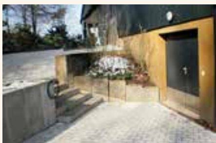
Neuer, jetzt ungefährlicher und bequemer Zugang zur unteren Caddiehalle mit Treppe
