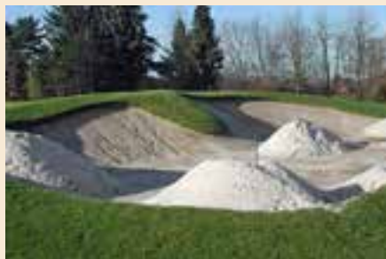
Sandaustausch aller Bunker - Westplatz
